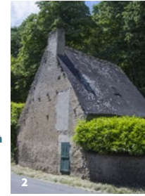
2. Maison ancienne à Port-Gautier
